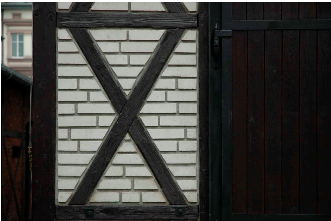
fot. 32 Muzeum Inżynierii Miejskiej w Krakowie – hala F, fragment elewacji wschodniej, widok: maj 2009
