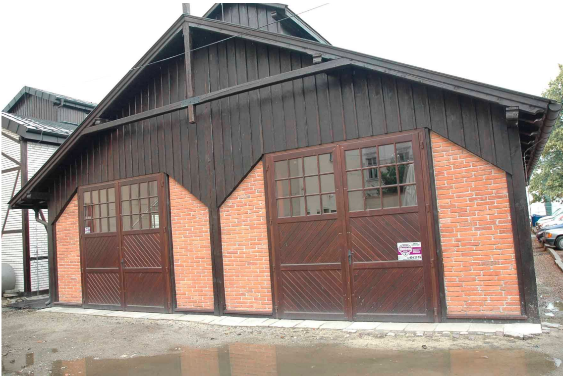
fot. 38 Muzeum Inżynierii Miejskiej w Krakowie, hala E, elewacja zachodnia, widok: maj 2009
