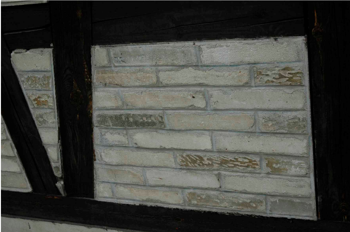
fot.47 Muzeum Inżynierii Miejskiej w Krakowie, budynek H, fragment elewacji południowej, widok: maj 2009
