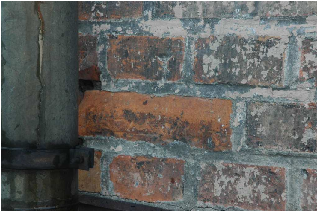
fot 6. Muzeum Inżynierii Miejskiej w Krakowie ul. św. Wawrzyńca 15 w Krakowie. Hala E – fragment wątku. Stan przed konserwacją.
