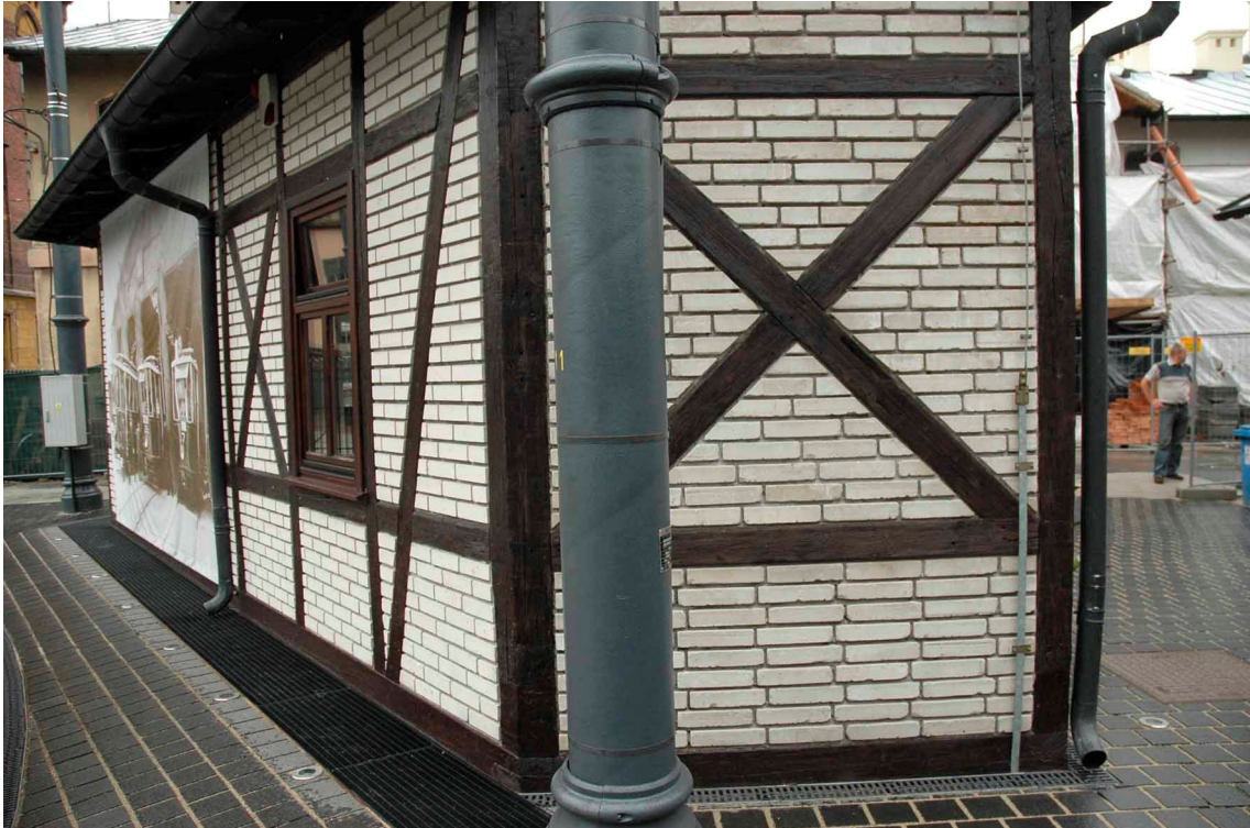
fot.31 Muzeum Inżynierii Miejskiej w Krakowie – hala J, elewacje północna i zachodnia, widok: maj 2009
