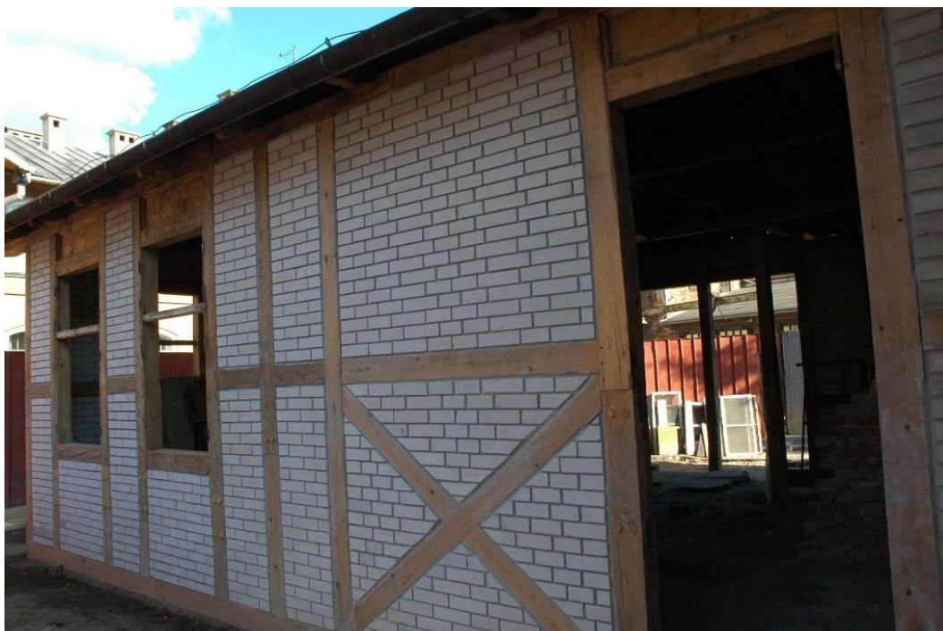
fot 15. Muzeum Inżynierii Miejskiej w Krakowie ul. św. Wawrzyńca 15 w Krakowie. Hala E – przybudówka. Stan po zrekonstruowaniu wątku ceglanego w strukturze muru.
