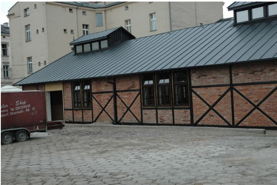
fot 14. Muzeum Inżynierii Miejskiej w Krakowie ul. św. Wawrzyńca 15 w Krakowie. Hala E. Stan po zrekonstruowaniu wątku ceglanego w strukturze muru.
