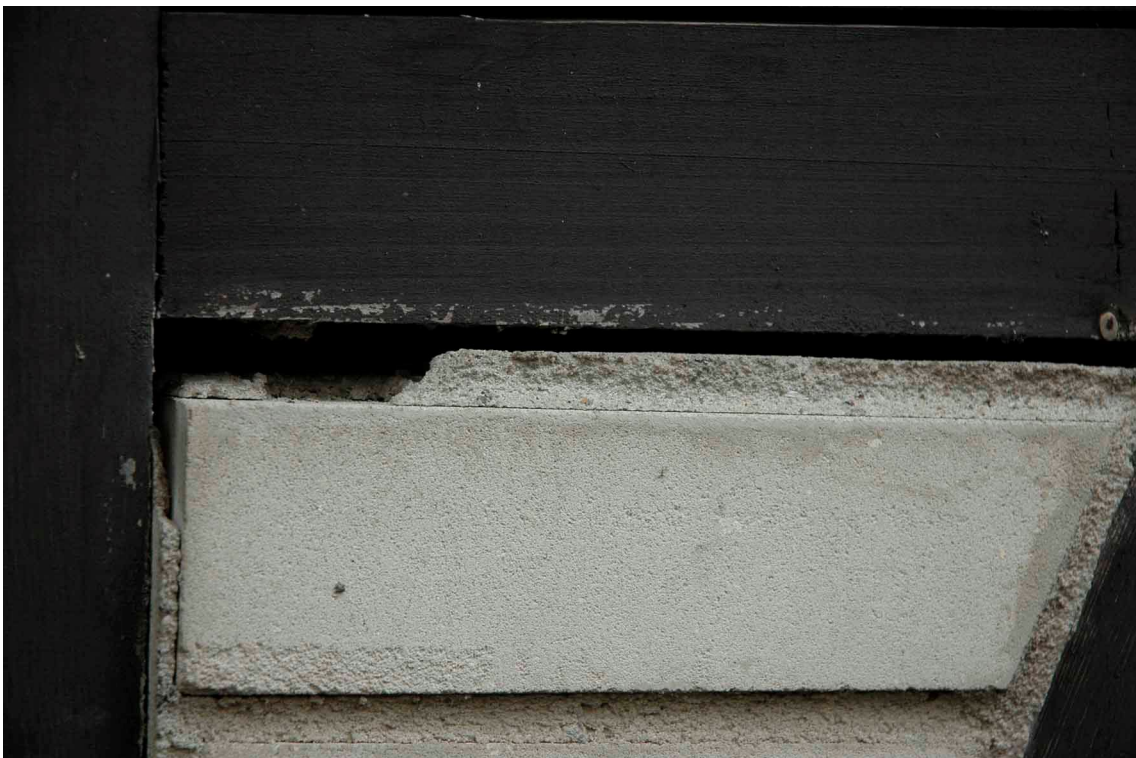
fot.44 Muzeum Inżynierii Miejskiej w Krakowie, budynek H, fragment elewacji północnej, widok: maj 2009
