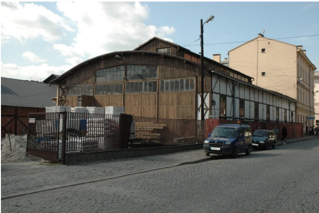
fot 3. Muzeum Inżynierii Miejskiej w Krakowie ul. św. Wawrzyńca 15 w Krakowie. Hala F – elewacja północna. Stan przed konserwacją.
