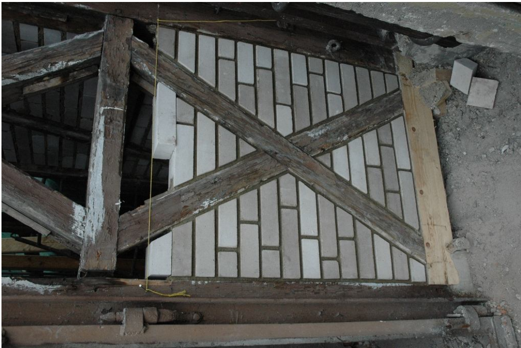
fot 9. Muzeum Inżynierii Miejskiej w Krakowie ul. św. Wawrzyńca 15 w Krakowie. Hala E – przybudówka. Rekonstrukcja wątku ceglano.
