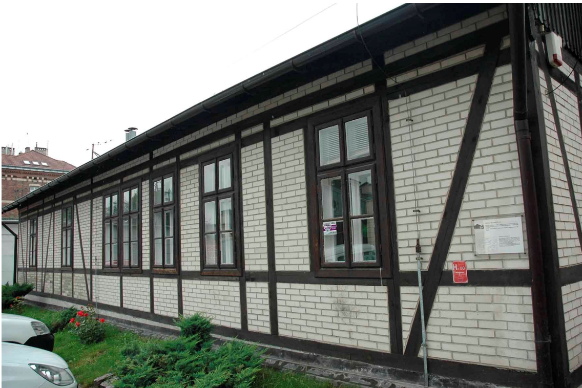
fot. 40 Muzeum Inżynierii Miejskiej w Krakowie, budynek H, elewacja wschodnia, widok: maj 2009
