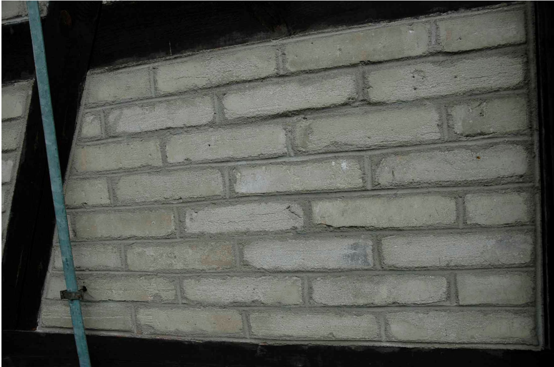
fot. 43 Muzeum Inżynierii Miejskiej w Krakowie, budynek H, fragment elewacji zachodniej, widok: maj 2009
