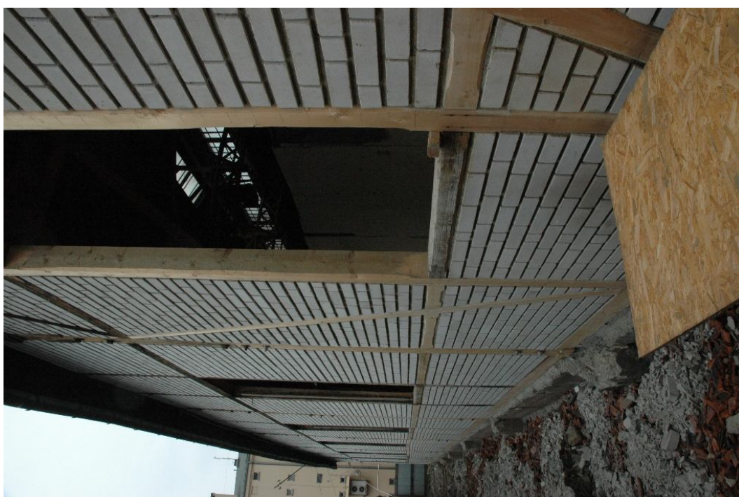
fot 16. Muzeum Inżynierii Miejskiej w Krakowie ul. św. Wawrzyńca 15 w Krakowie. Hala F. Stan po zrekonstruowaniu wątku ceglanego w strukturze muru.
