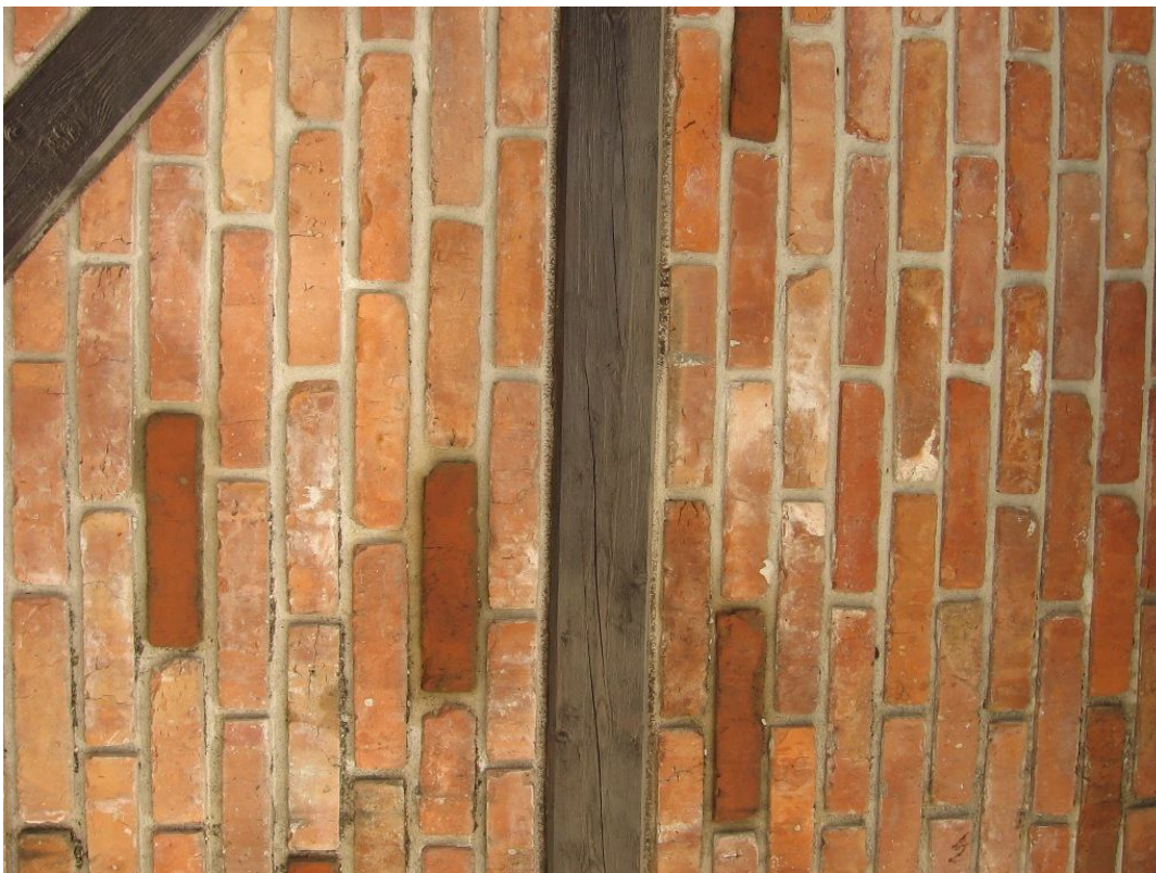
fot 19. Muzeum Inżynierii Miejskiej w Krakowie ul. św. Wawrzyńca 15 w Krakowie Hala E. Fragment wątku – stan obecny.
