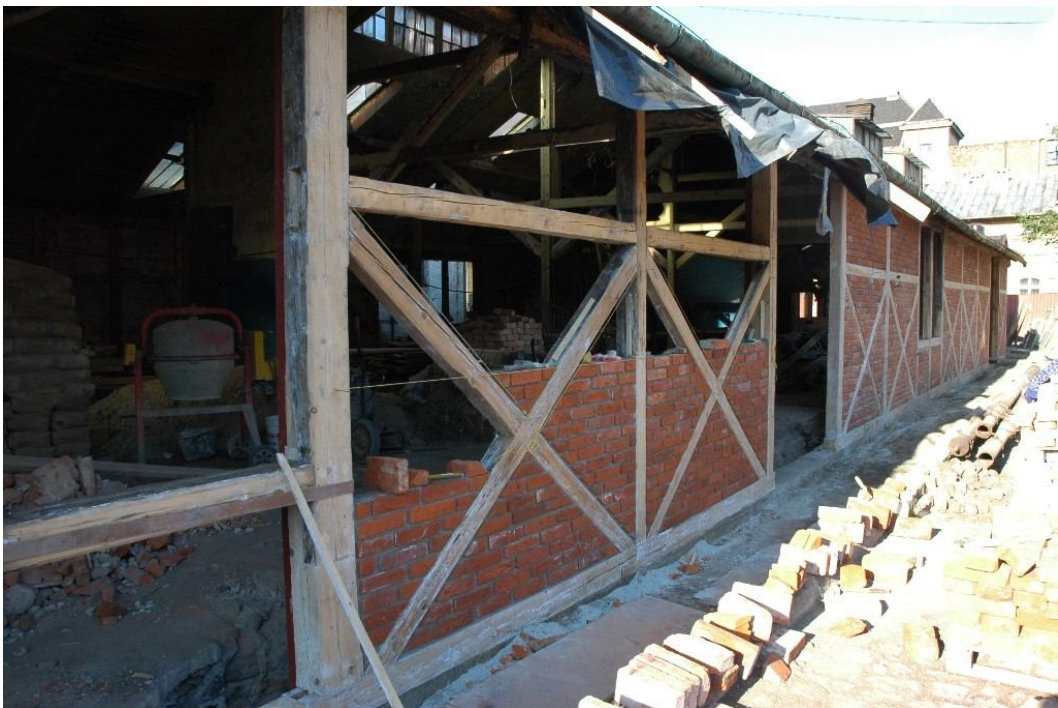
fot 10. Muzeum Inżynierii Miejskiej w Krakowie ul. św. Wawrzyńca 15 w Krakowie. Hala E . Rekonstrukcja wątku ceglano.
