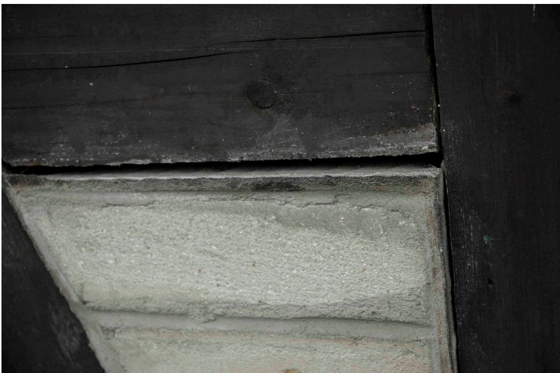
fot.46 Muzeum Inżynierii Miejskiej w Krakowie, budynek H, fragment elewacji wschodniej, widok: maj 2009
